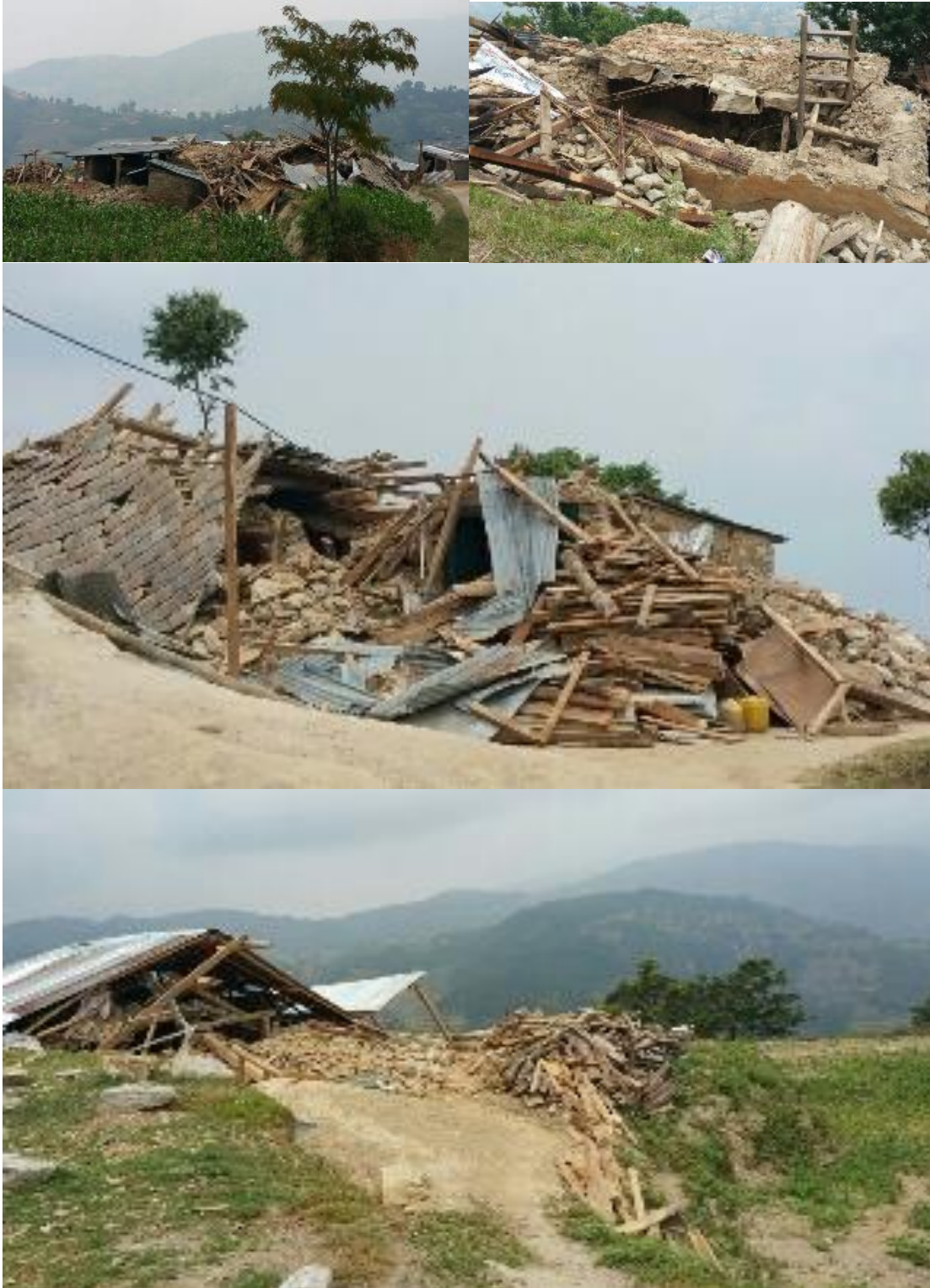
De ingestorte huizen in het dorp.
